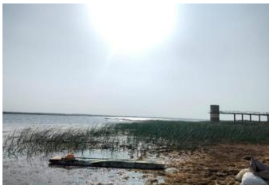
Plate No. 4: Harsoor dam
